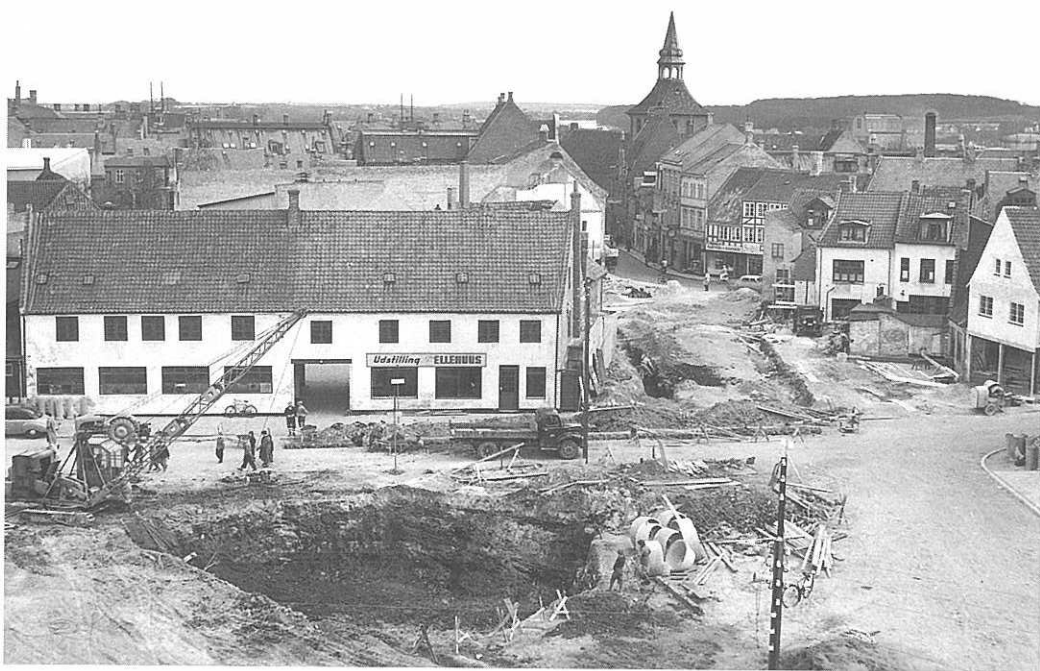
Centrumpladsen og gadegennembrud i Gerritsgade.
